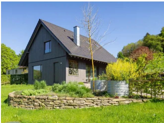
Einfamilienhaus in der Eifel, Holzständerbauweise mit esb-Plus Holzbauplatten und ClayTec Lehmputz im Innenbereich | Ausführung Zimmerei Krings Reinke, Monschau
