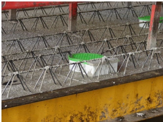
Elektroinstallation in Ortbeton
