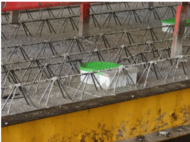
Elektroinstallation in Ortbeton
