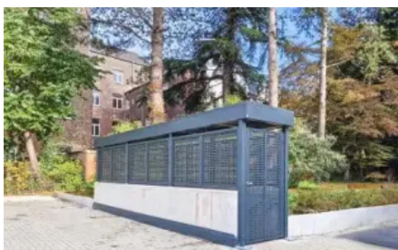
Überdachung für einen Tiefgarageingang mit Drehflügeltür und Sichtschutz aus Stahl mit Quadratlochung
