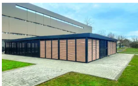
Einhausung für Fahrräder und Mülltonnen mit Sichtschutz in Stahl mit Quadratlochung, Langlochung und Aluminiumlamellen in Holzdekor
