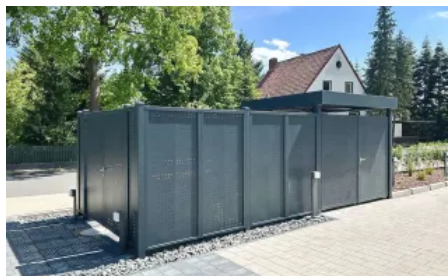
Einhausung für Mülltonnen mit Sichtschutzelementen aus Stahl in Quadratlochung
