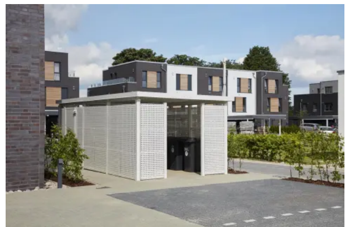
Müllhaus, Lochblech pulverbeschichtet
