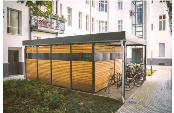
Mülleinhausung und Fahrradüberdachung, Gründach light, Woodline Design
