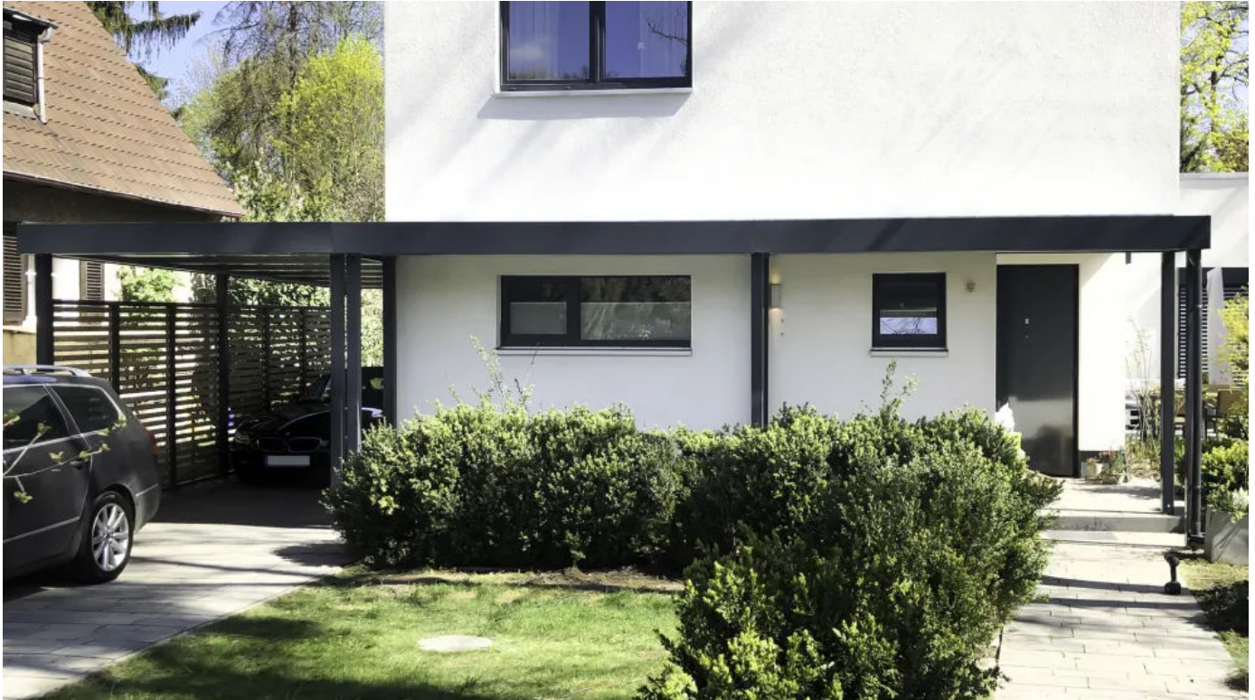
Vordach CP als weiterführende Eingangüberdachung zum Carport
