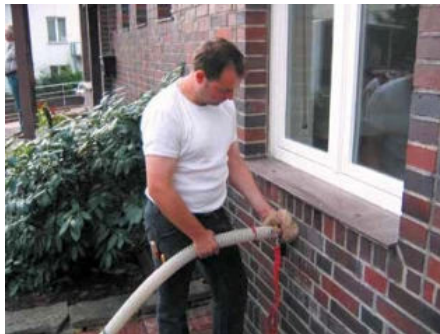
Für die Einblasdämmung erforderliche Bohröffnungen in der Fassade werden nahezu unsichtbar wieder verschlossen.
