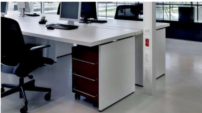
Geräteeinbaudosen und Abdeckrahmen ermöglichen den Einbau von Modul 45-Geräten in Installationssäulen mit 80er Systemöffnung.
