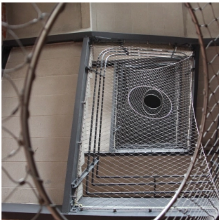
X-Tend im Treppenhaus
