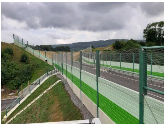
Fledermausschutz Oberlauchringen (© Carl Stahl ARC)
