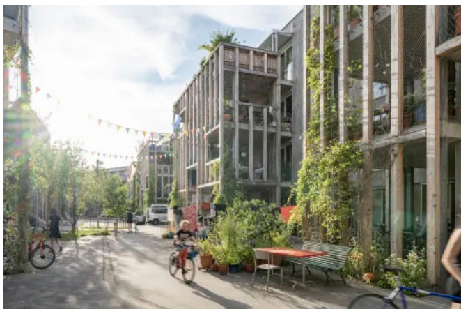
GREENCABLE® Begrünungssysteme | WBG Hübergass, Bern (© Thomas Haug)
