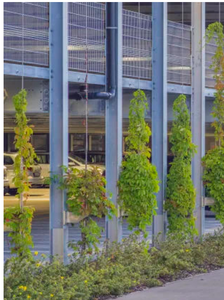
Parkhaus Kempten (© Baldauf & Baldauf Fotografie)
