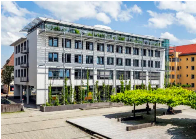
Fassadenbegrünung | Technisches Rathaus, Friedrichshafen (© Guido Kasper)
