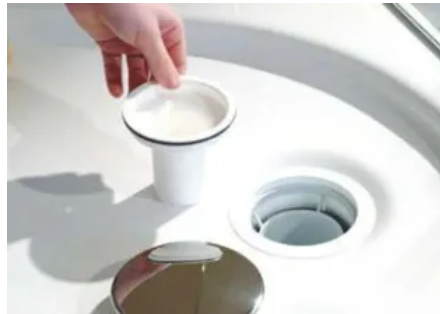
Geruchverschluss entfernen
