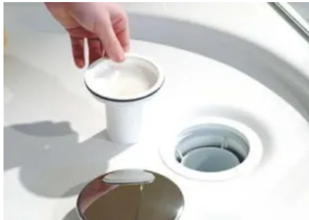
Geruchverschluss entfernen
