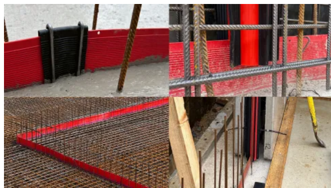
Fugenband und Fugenblech, Sternrohr
