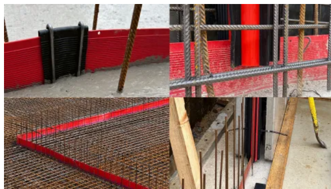
Fugenband und Fugenblech, Sternrohr
