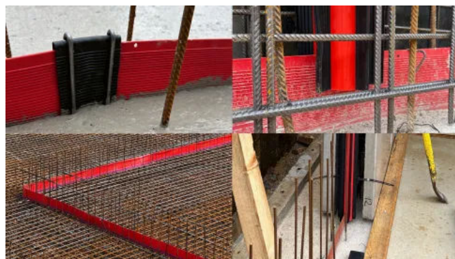
Fugenband und Fugenblech, Sternrohr
