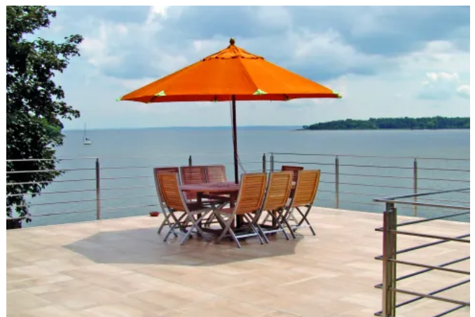
Dauerhaft schadensfreie Balkone dank Schlüter®-Systems
