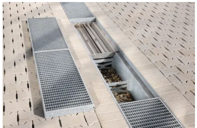
Die Rinnen eignen sich bestens für die Zwischenspeicherung großer Wassermengen und die anschließende, fortwährende Dränierung
