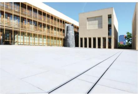
Auch vor den Fassaden sämtlicher Gebäudeteile der Moschee sorgt das Entwässerungssystem für die sichere Ableitung von
