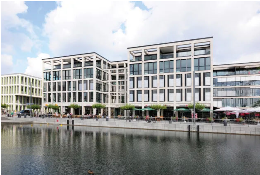
Das RIVA 1 an der Hafepromenade am Dortmunder Phoenix See ist ein fünfgeschossiges Bürogebäude inklusive Gastronomie und Penthousewohnungen, entworfen vom Architekturbüro Schamp & Schmalöer.
