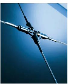
Durch eine kreuzförmige Verbindung sind die Stahl-Elemente zur Aussteifung tragender Elemente nutzbar.
