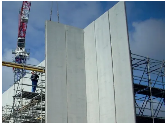
Montage der Fehr-Doppelwand
