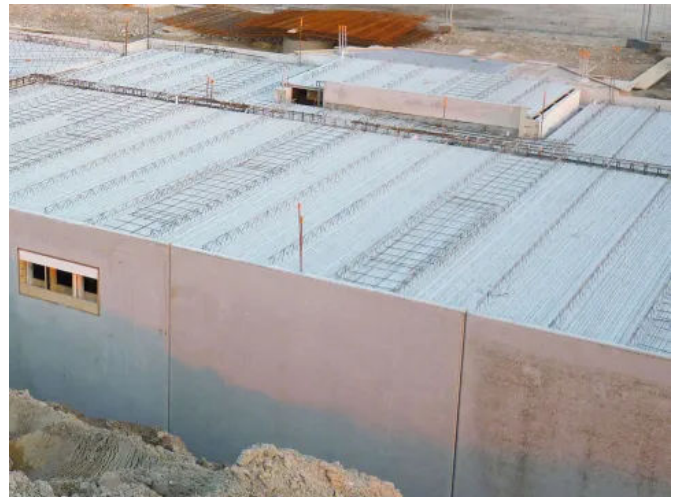
Verlegung der Fehr-Elementdecke
