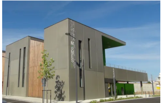
Schulgebäude - Bourg Lès Valence; Architekt: Rue Royale Architectes
