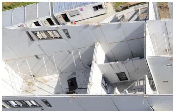
Montierte Doppelwände
