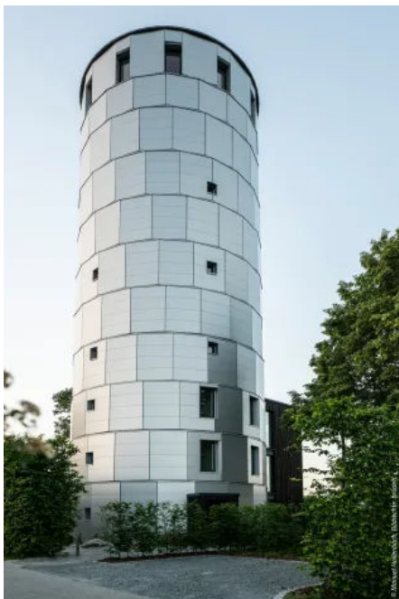
Wasserturm von Pirach
