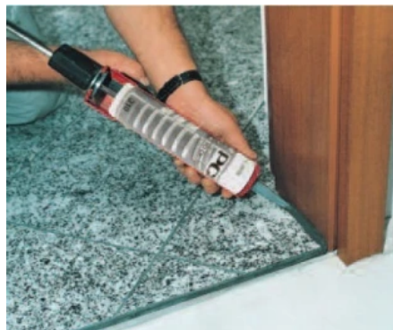
Durch den Einsatz von PCI Carraferm entstehen keine Randzonenverfärbungen bei Naturwerksteinen.
