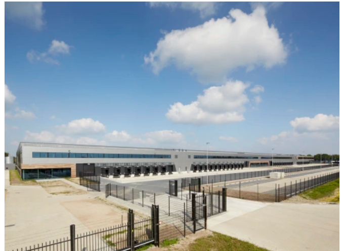
Logistikobjekt — Detektionssystem GeoMic
