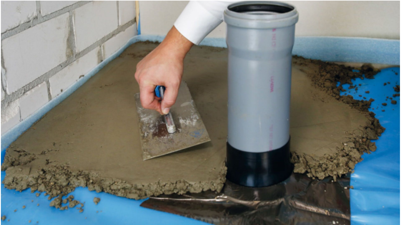
Luftdichtungsmanschetten zur Abdichtung von Durchbrüchen im Bodenbereich
