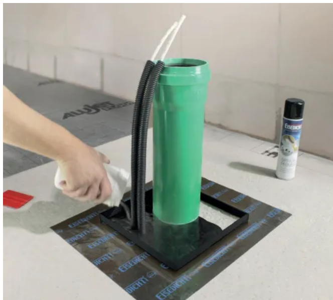
VergussDICHT bei eng nebeneinander liegenden Versorgungsleitungen
