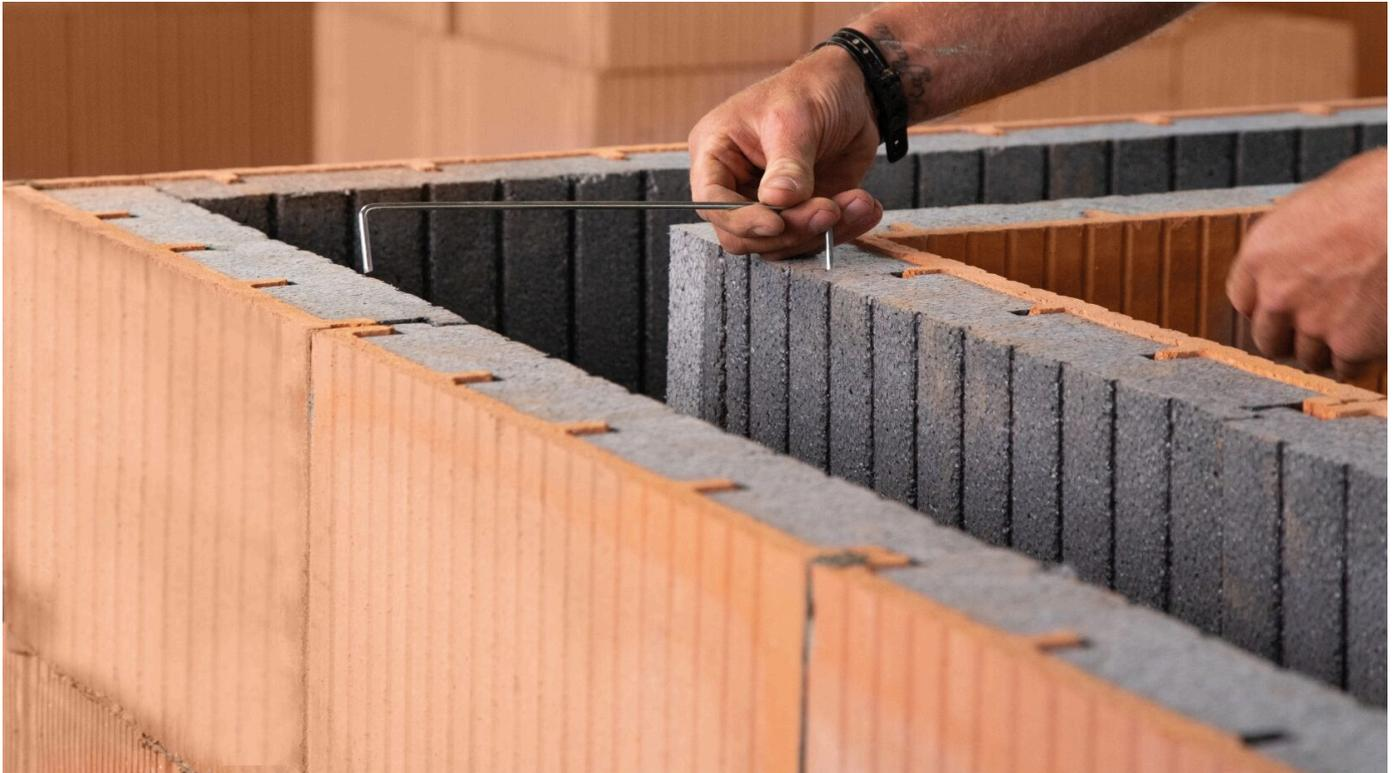
Detail-Lösungen mit POROTON®-Ziegelzubehör ermöglichen nicht nur einen einheitlichen Putzgrund, sondern auch Wärmebrückenoptimierung und eine Reduzierung der Schallübertragung. Von Deckenrandschalen über Stützendämmschalungen bis hin zu Höhenausgleichsziegeln und Kimmziegeln erfüllt das POROTON®-Ziegelzubehör als "Dämmung mit Ziegelschale" die Anforderungen an Wärmeschutz, Schallschutz und Brandschutz.
