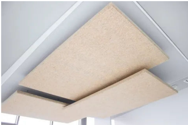
Die Deckensegel Selecta Hemp bestehen aus nachwachsenden Hanffasern. (© OWA)
