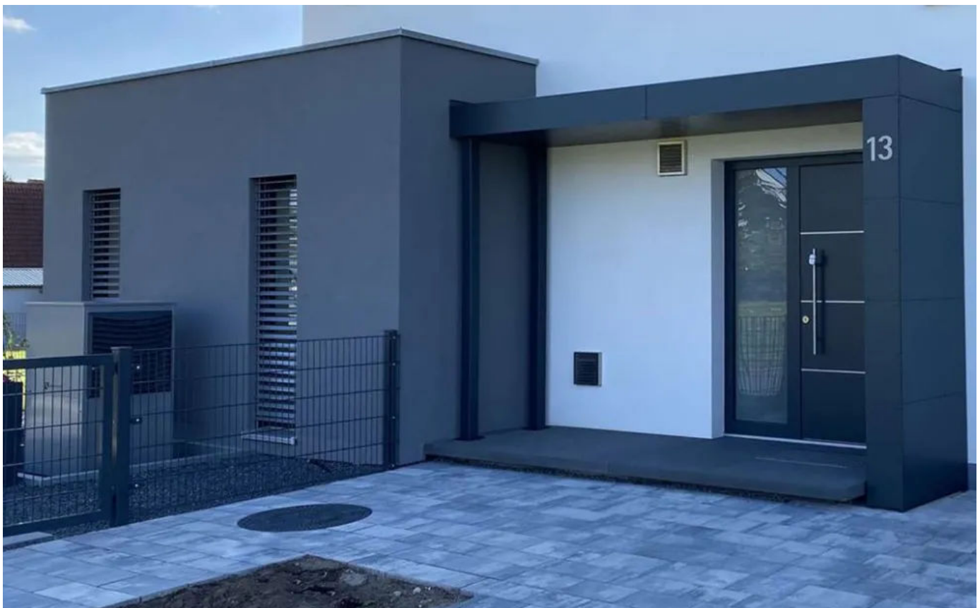
Vordach in L-Form mit 2 Stützen und Hausnummer
