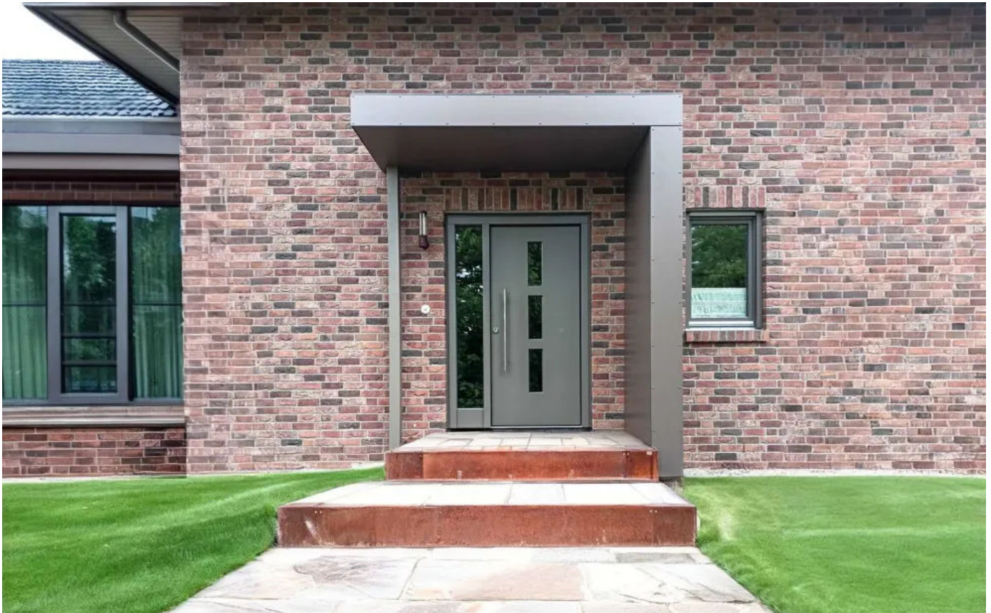
Vordach in L-Form mit einer Stütze
