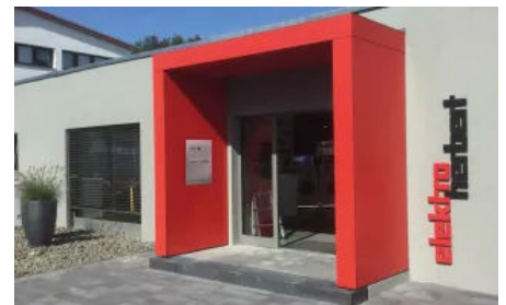
Vordach S.1 in U-Form , mit Briefkastenanlage
