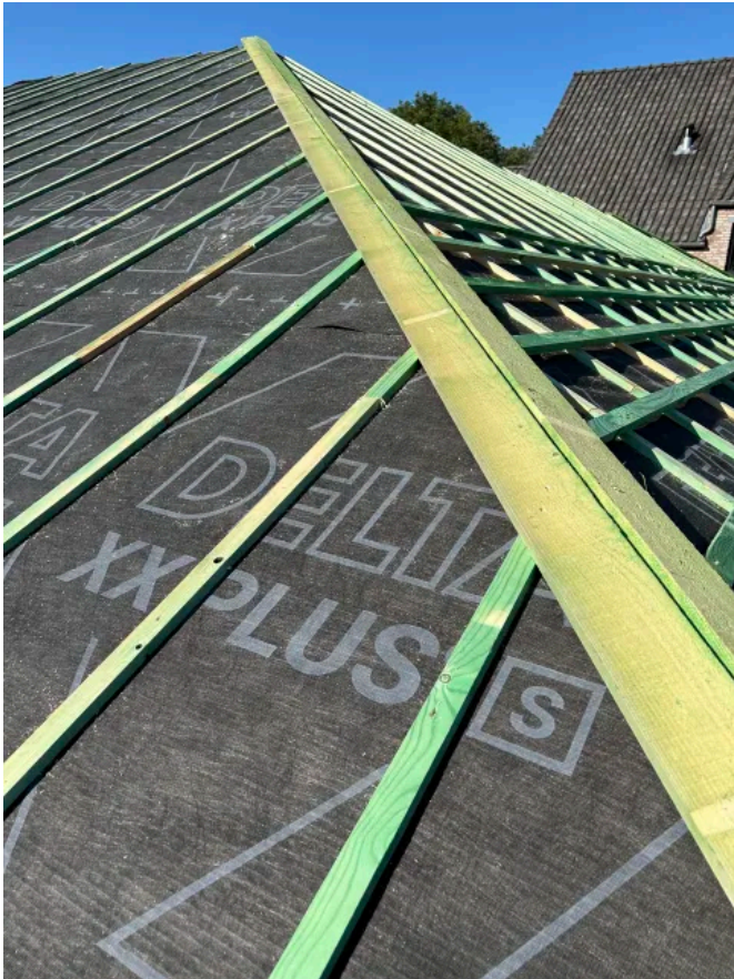
DELTA-XX PLUS® STRONG speziell für Dächer mit großen Lattweiten
