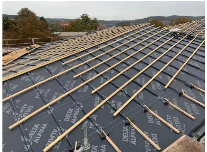
DELTA®-ALPINA kann durch den symmetrischen Aufbau seitenunabhängig verarbeitet werden
