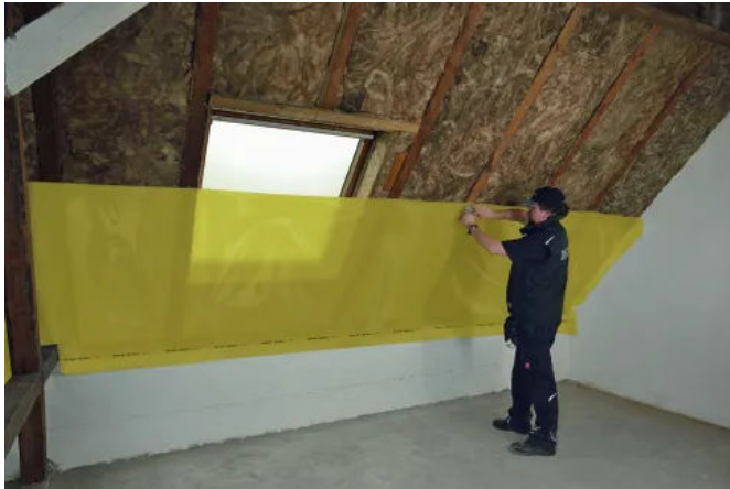
Einfache Fixierung mit Tackerklammern
