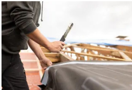
DELTA-XX PLUS® UNIVERSAL an Unterkonstruktion tackern
