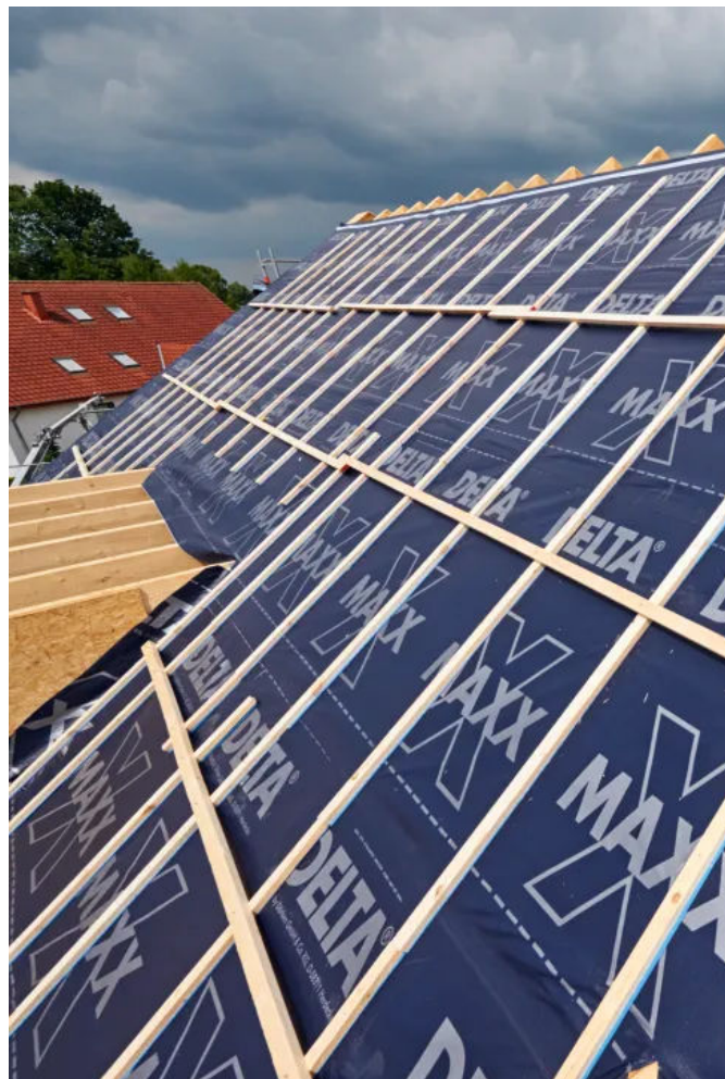
DELTA®-MAXX X für Dächer mit großen Lattweiten
