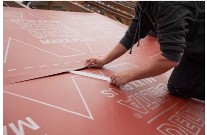
DELTA®-MAXX PLUS mit patentierten Selbstkleberändern
