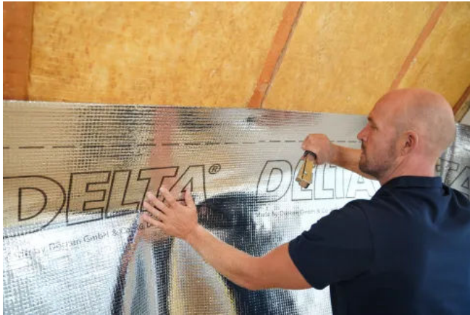
DELTA®-REFLEX bewirkt optimierten Wärmeschutz durch Wärme-Reflexion
