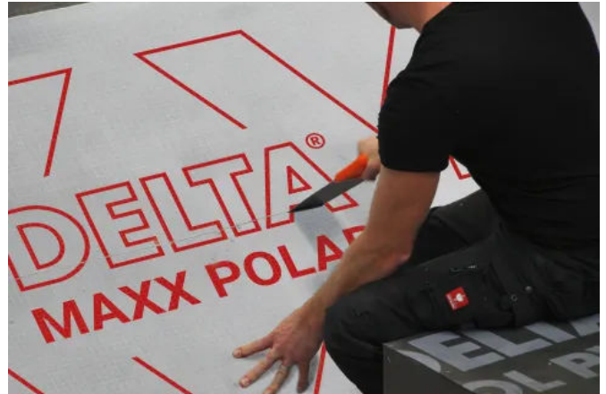
Die Dämmplatten besitzen eine robuste, rutschhemmende Oberfläche
