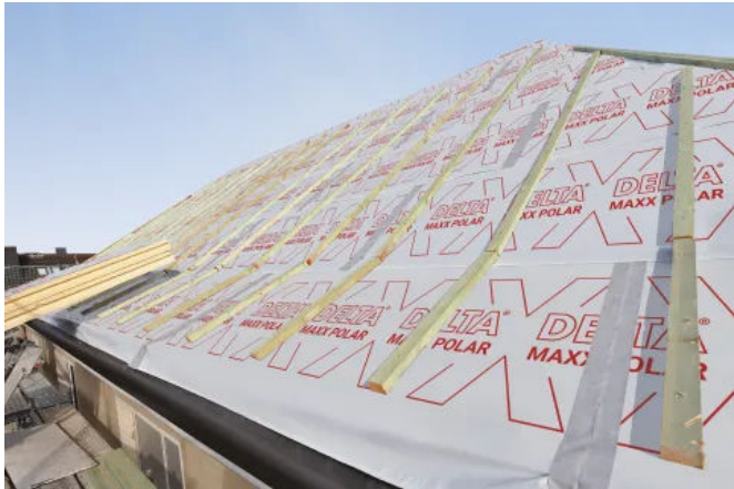
DELTA®-MAXX POLAR AL mit aufkaschierter Unterdeckbahn
