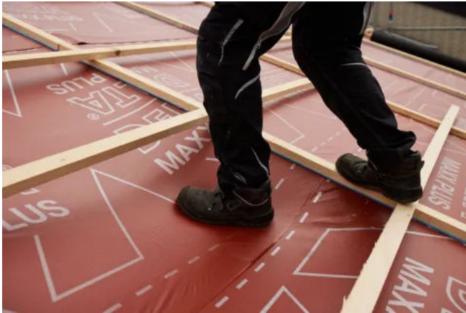
DELTA®-MAXX PLUS bietet geprüfte Durchsturzicherheit
