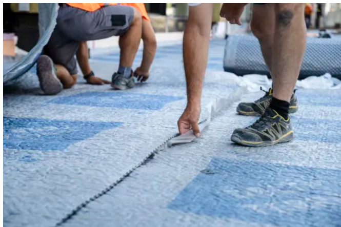
DELTA®-TERRAXX mit integrierten Selbstklebeband (© Photo: Martin Matula Photography)
