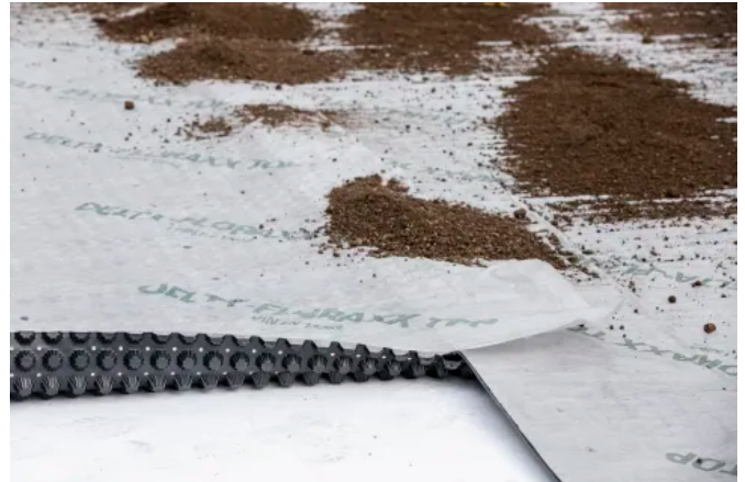
Das aufkaschierte Geotextil verhindert zuverlässig das Zuschlammern der Noppenbahn (© Photo: Martin Matula Photography)
