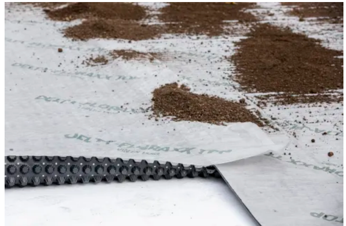
Das aufkaschierte Geotextil verhindert zuverlässig das Zuschlammten der Noppenbahn (© Photo: Martin Matula Photography)
