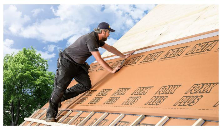
Schalungsbahnen werden während der Dacheindeckung hohen Belastungen ausgesetzt. Neben Witterungseinflüssen müssen sie auch hohen mechanische Belastungen durch das Begehen standhalten.
