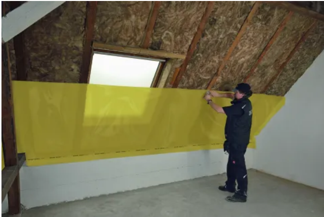
Einfache Fixierung mit Tackerklammern
