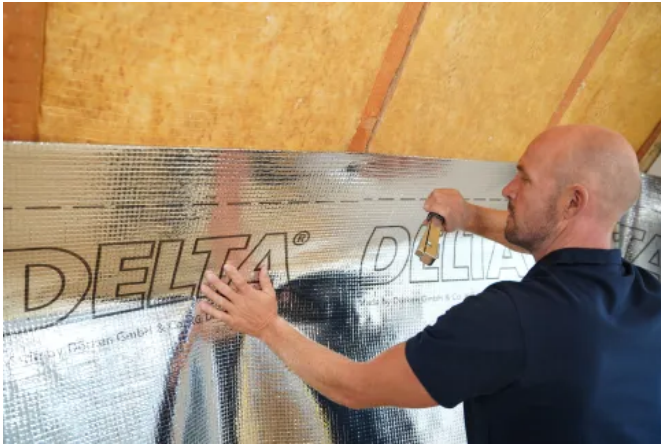
DELTA®-REFLEX bewirkt optimierten Wärmeschutz durch Wärme-Reflexion
