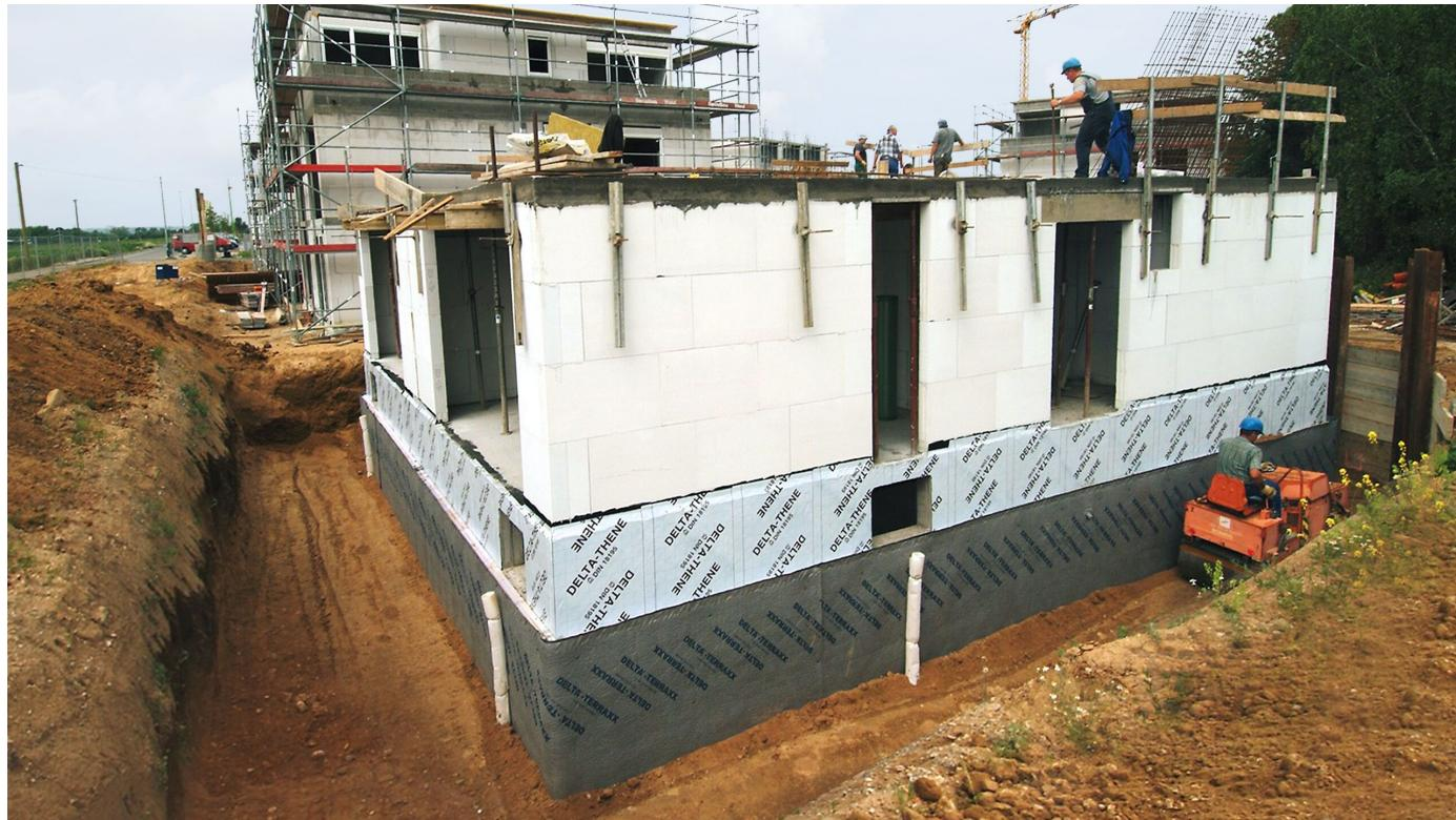
Schutz- und Dränagebahnen für die vertikale oder horizontale Anwendung im Keller.
