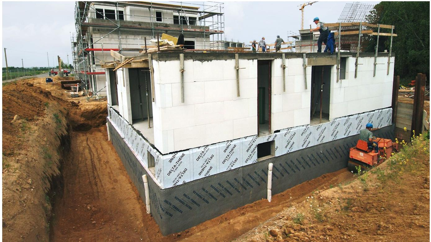
Schutz- und Dränagebahnen für die vertikale oder horizontale Anwendung im Keller.
