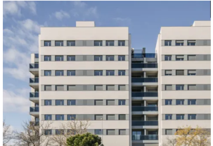
DKT2 Projektbeispiel: Valdebebas Building, Madrid
