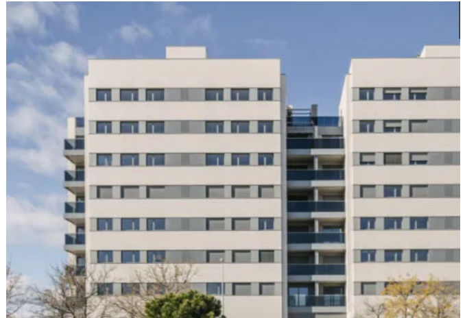
DKT2 Projektbeispiel: Valdebebas Building, Madrid
