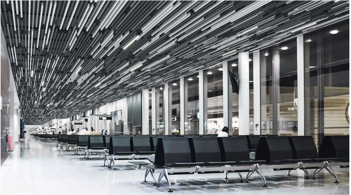
Das Combi-Line-Trägersystem für kreative Deckendesigns bietet Architekten zahlreiche Gestaltungsmöglichkeiten und kombiniert verschiedene Deckenpaneele aus dem Luxalon®, HeartFelt® und Derako® Produktsortiment geschickt miteinander.
