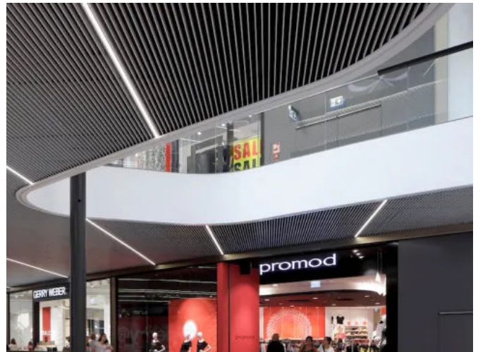
Einzellamellen zur bauseitigen Steckmontage: System K9
