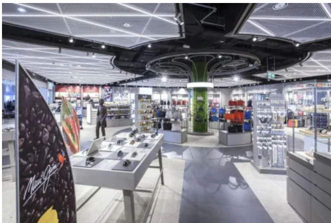
Streckmetalldecke (Referenz Satellit Flughafen München)
