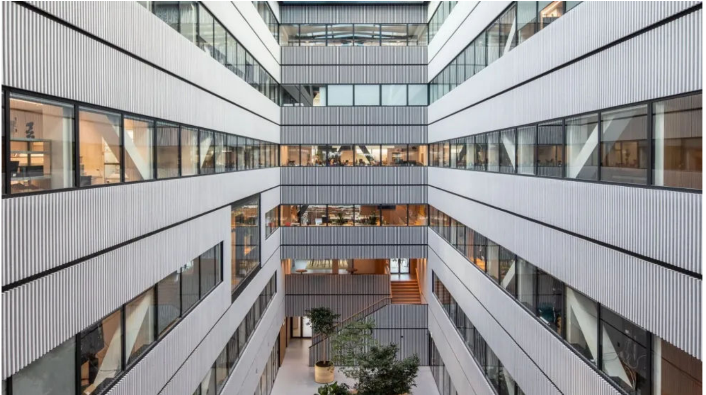
HeartFelt® Lineare Wände im Innovationszentrum Matrix ONE in Amsterdam, Niederlande, Architekt: MVRDV
