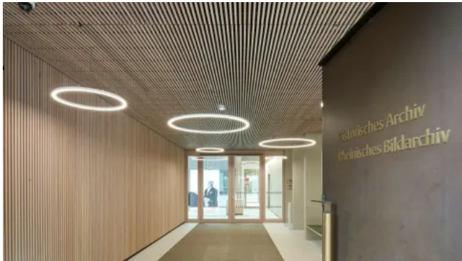
Massivholzraster system für Wände im Historischen Archiv in Köln, Architekt: Waechter + Waechter
