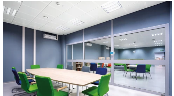
Metalldecken mit sichtbarer Unterkonstruktion (© Szymon Polański)
