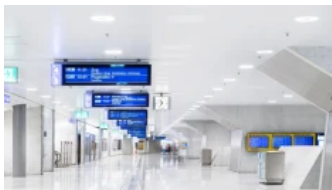
Metalldecken mit sichtbarer Unterkonstruktion Armstrong METAL Q-Clip, Q-Clip F, S-Clip F (© Foto Lautenschlager)
