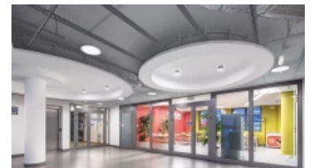
Metalldecken mit sichtbarer Unterkonstruktion Armstrong MESH R-Clip, R-H 200, R-H 200 MT, R-H 215 (© Szymon Polański)
