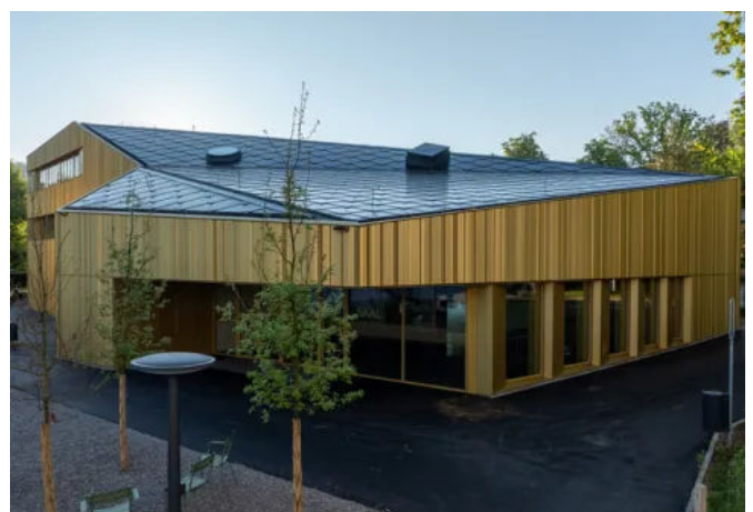
Gemeindehalle - Arlesheim | ©SunStyle® | Integration der Solardachziegel in komplexe Dachgeometrien mit flachen Neigungswinkeln
