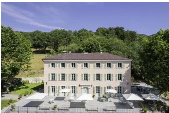
Das Wohnhaus wurde mit einem Solardach in Terrakotta-Farbe ausgestattet | ©SunStyle®
