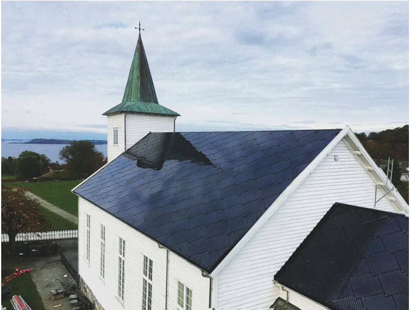
Das ursprüngliche Schindeldach wurde durch Solardachziegel von SunStyle ersetzt | ©SunStyle®
