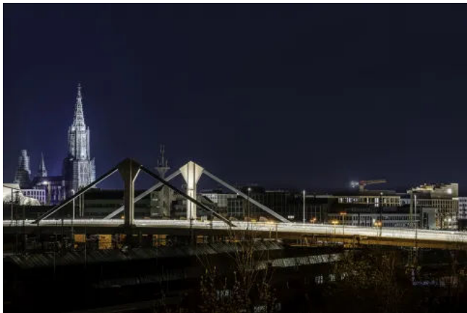
Handlaufsystem LUX GLENDER ULTRA SAFE - Ludwig-Erhard-Brücke in Ulm | Ausführung: Lichtaustritt asymmetrisch, IP69
