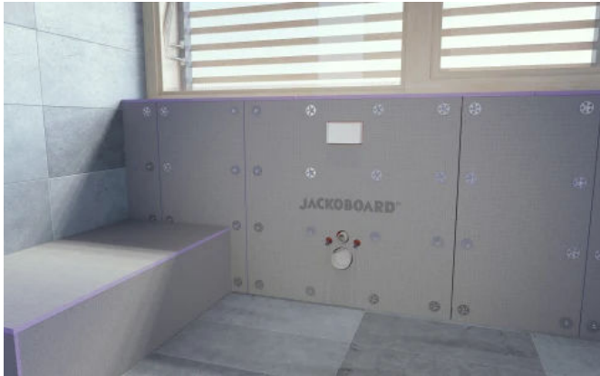
Badausbau mit JACKOBOARD® Sabo und JACKOBOARD® Plano Bauplatten
