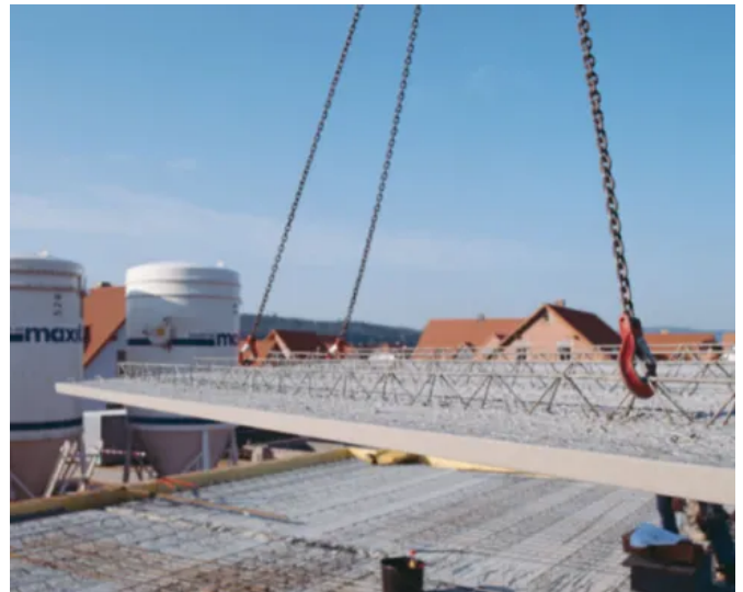
Elementdecke in der Montage
