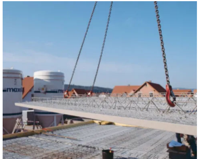
Elementdecke in der Montage
