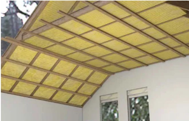
Dachschrägenbekleidungen können mit Unterkonstruktionen aus Holzlattung oder Metallprofilen (CD- oder Hut-Deckenprofile) ausgeführt werden.
