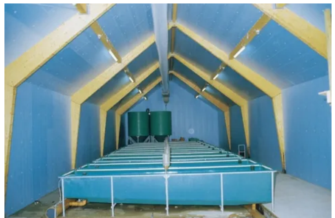
Dämmung eines Beckens für Fischzucht
