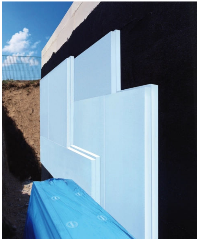
Mehrlagige Perimeterdämmung
