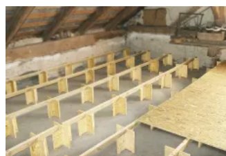
Deckenkonstruktion mit montierter Dämmständerkonstruktion WoodyFIX
