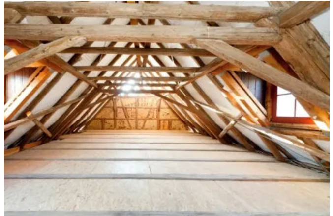
Schrägdächer lassen sich mit Glaswolle sicher und wirksam dämmen.
