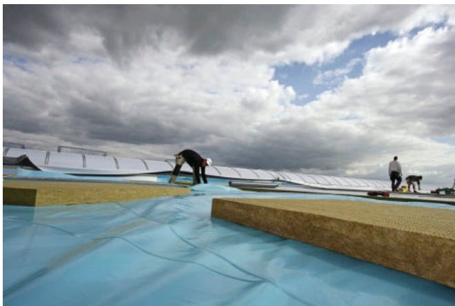
Steinwolle-Dämmstoffe sorgen auf Flachdächern für einen sicheren Wärmeschutz.
