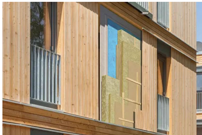
Die Dämmung mit Steinwolle ist für den Einsatz im Holzbau besonders geeignet.
