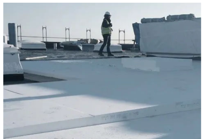
Verlegebeispiel EPS Flachdach-Dämmplatten
