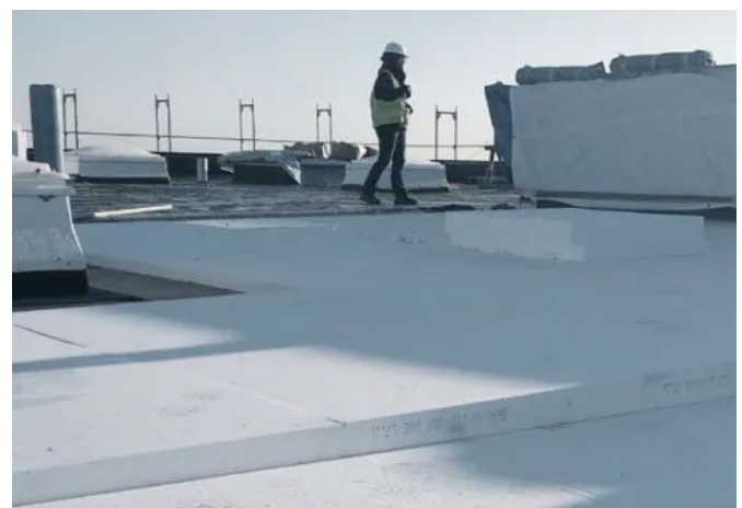
Verlegebeispiel EPS Flachdach-Dämmplatten
