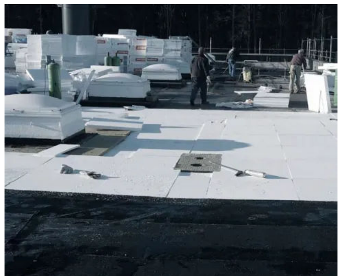
Verlegbeispiel EPS Gefälle-Dämmplatten
